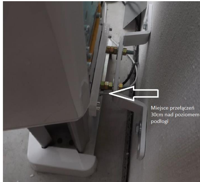
Rysunek 5 Miejsce podłączeń przewodów
